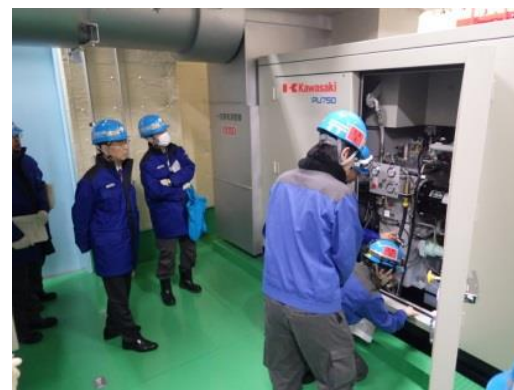
▲ 自家用発電設備を実際に稼働させ手順を確認
