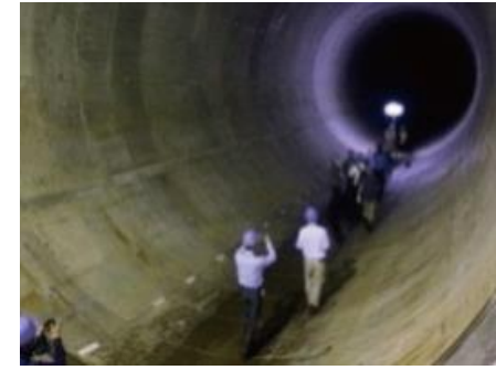
【第二溜池幹線現場見学会の様子】
