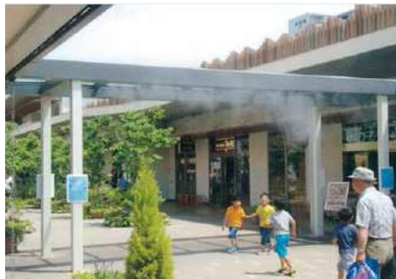
クールスポット創出支援事業による微細ミスト設置例
