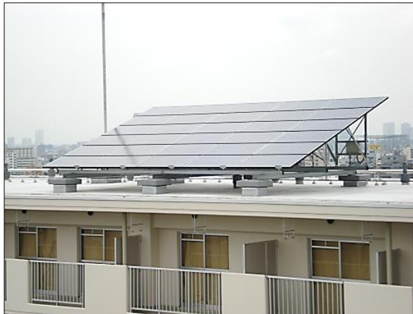
太陽光パネル
