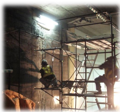
長寿命化工事
