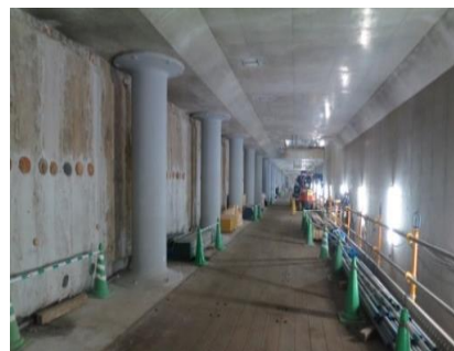
勝どき駅コンコース新設工事
