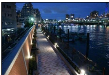
夜間照明の設置
