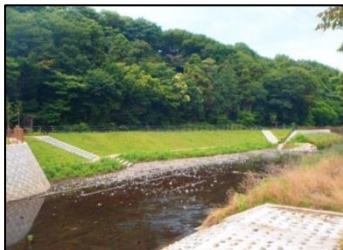
緩傾斜型護岸（境川）
