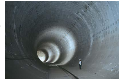
神田川・環状七号線地下調節池
