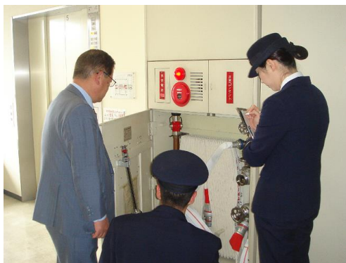
立入検査専従職員による立入検査
