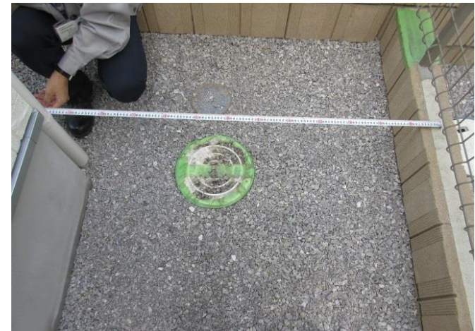
完了検査の様子
