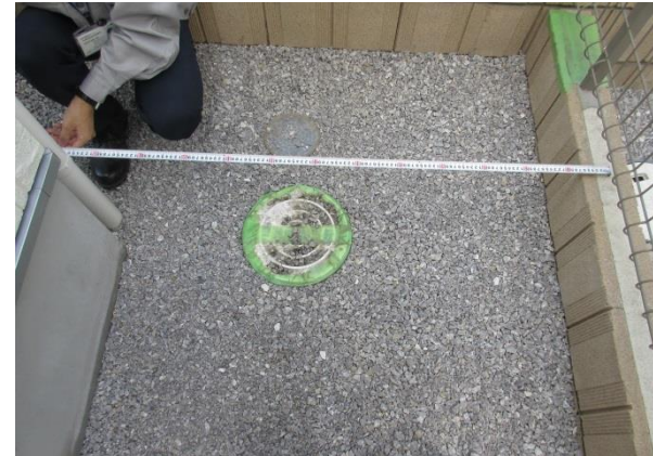
完了検査の様子
