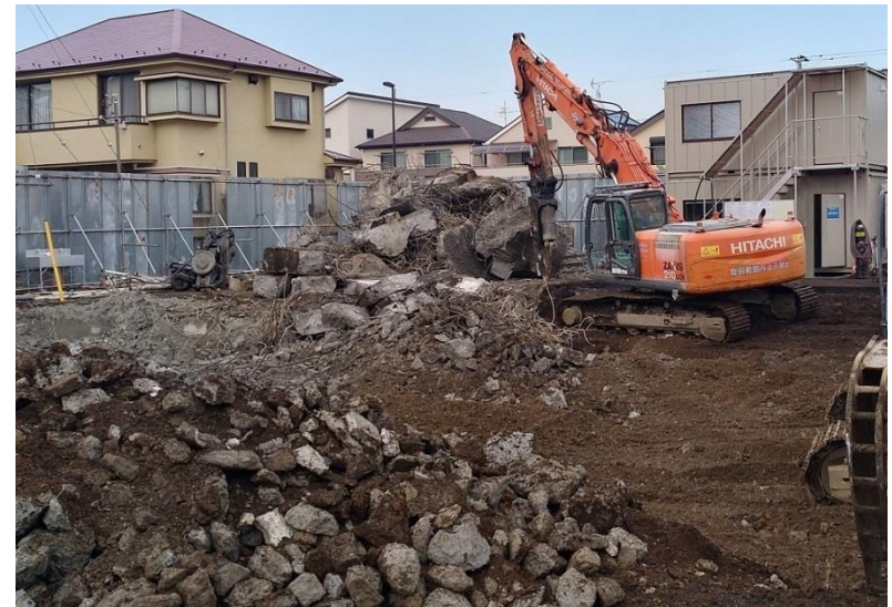
解体現場での仕分け作業
