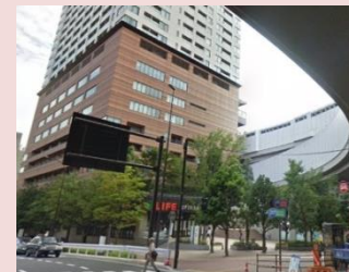
▲1-1棟前に整備された大広場
