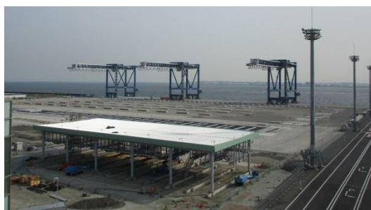
Y2コンテナヤード工事状況(H30.4)
