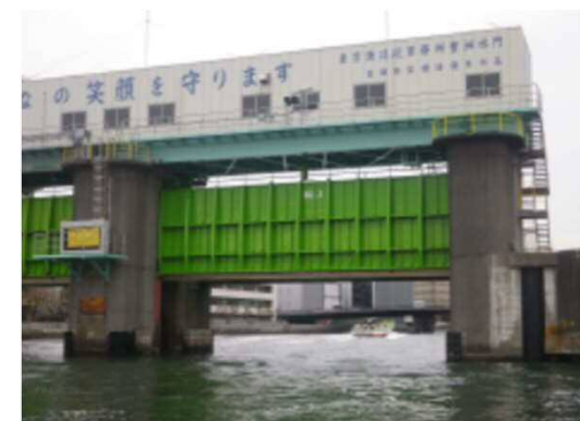
水門門扉の腐食防止のため、塗装を塗替え、長寿命化を図る。
