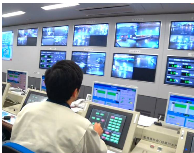
水門の操作状況
