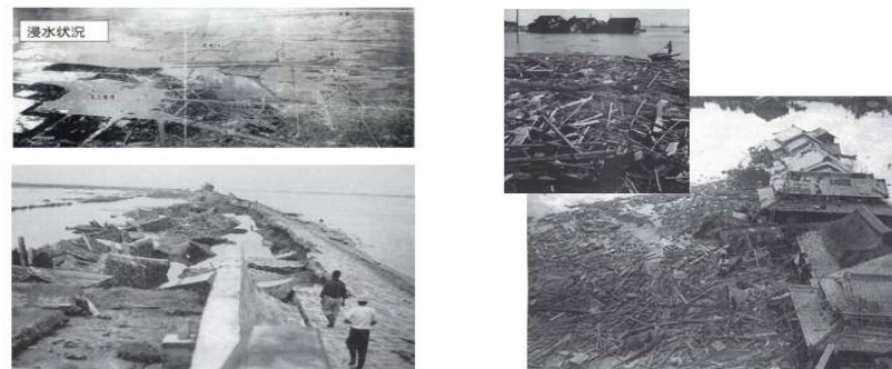
海岸堤防の被災状況
