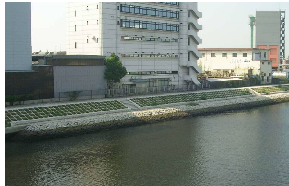
防潮堤(京浜運河)
