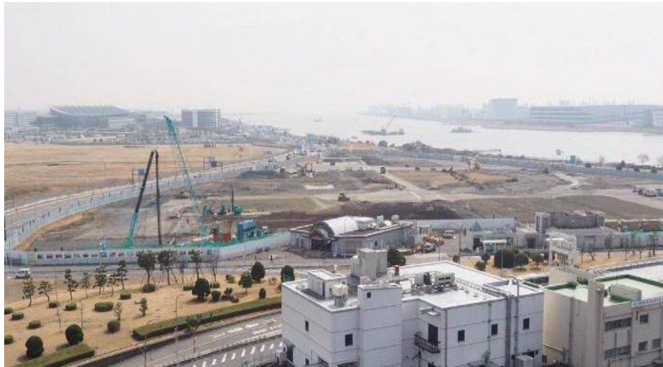
羽田空港跡地地区土地区画整理事業の基盤整備工事状況 平成30年3月撮影 (出典:大田区HP)
