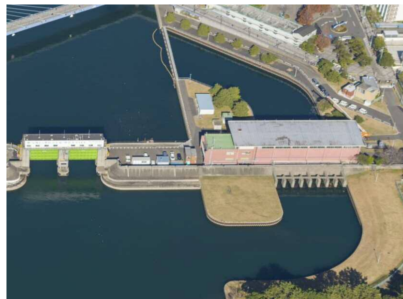
辰巳排水機場
