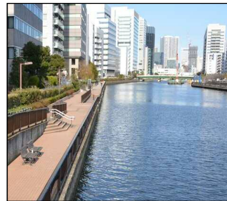
内部護岸(高浜運河)
