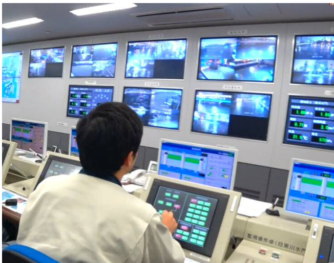
水門の操作状況
