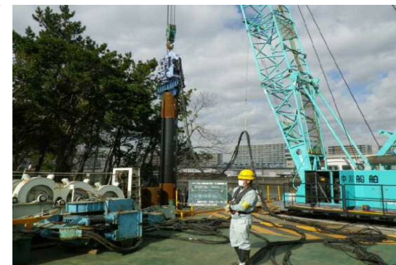
バイブロハンマ工法
