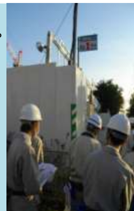
工事安全パトロールの様子
