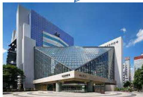
SRC (一部S) 造 地上10階、地下4階 劇場の特所の一つとして、世界最大級のパイオルガンを有する。
