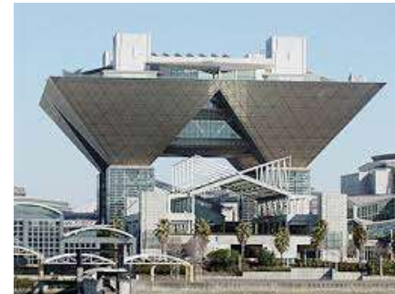
SRC、RC、S造 最高地上8階、地下1階 高層棟の逆三角形は東京のシンボル。
