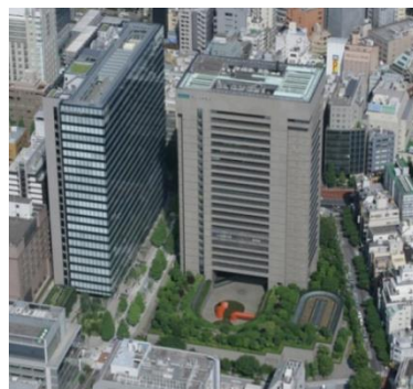
三井住友海上駿河台ビル 及び駿河台新館
