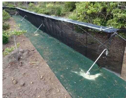
拡散防止柵 Cライン
