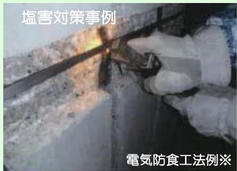
※ 電気防食工法：微弱な電流を流すことで鉄筋の酸化による腐食を抑制する工法
