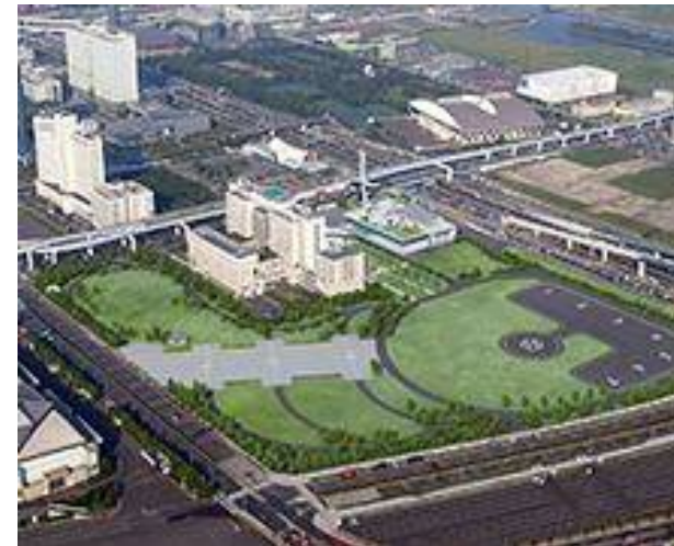
広域防災拠点【提供：東京臨海広域防災公園】
