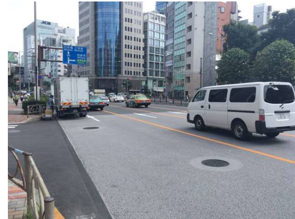
ロードレースコースを始めとした 道路への遮熱性舗装導入
