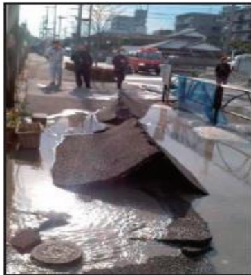
液状化による噴砂発生状況
