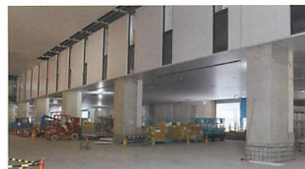
1階 搬出入口(2015年10月撮影)※
